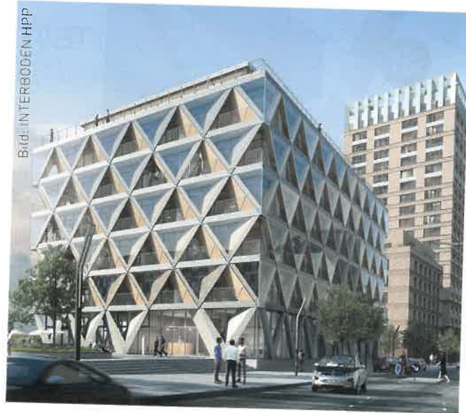
40221 Düsseldorf | The Cradle | HPP Architekten / INTERBODEN
