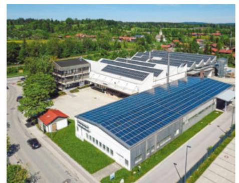
/ Erneuerbare Energie: Auf den Dächern ist eine Photovoltaikanlage mit 400 kW installiert.
